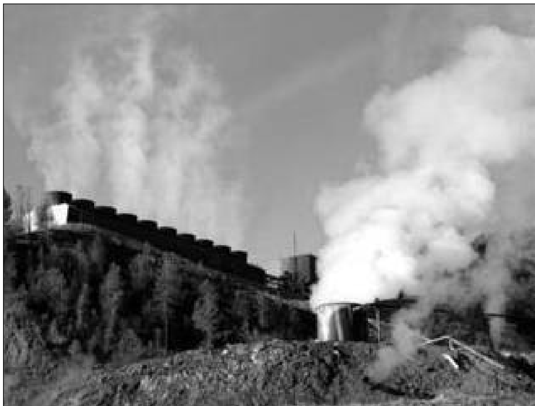
Dave Parsons / NREL / px 01045
